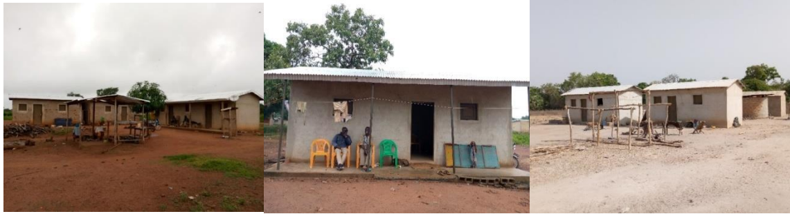
Figure N°1 : les constructions de maisons dans les villages riverains
