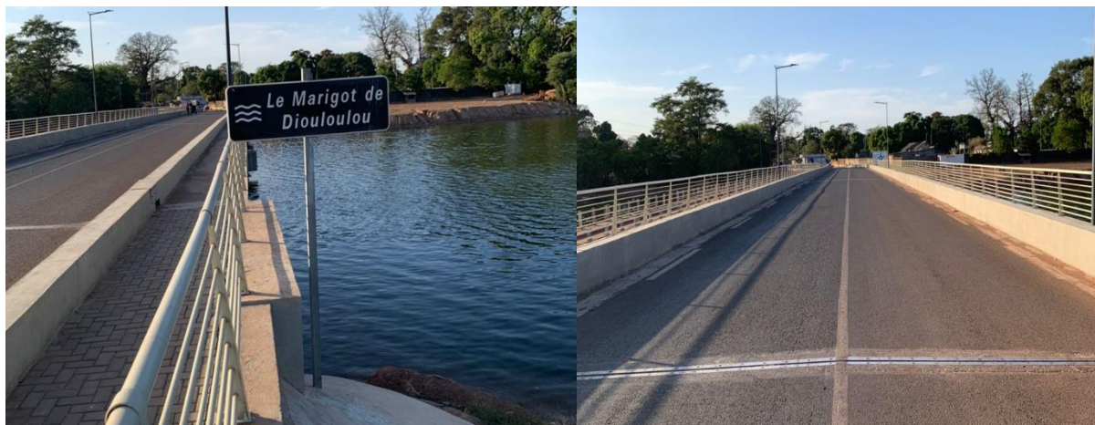
Figure 6 : Pont de Diouloulou inauguré le 16 janvier 2024.
